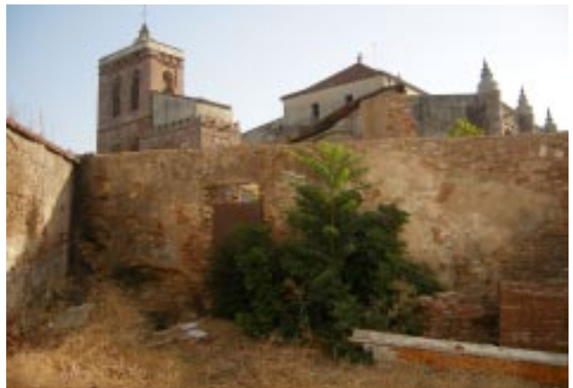
Patio de la Iglesia en estado anterior al comienzo de las obras
